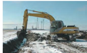
Travaux de reprofilage de la pente pour stabiliser les berges.
