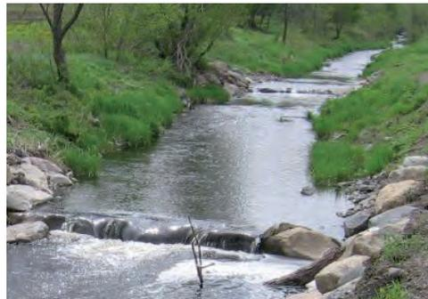
*Exemple de seuil dissipateur d'énergie (chute enrochée) dans le fond du cours d'eau pour contrôler la vitesse d'écoulement de l'eau et à réduire les exercées par l'eau sur les berges.*
