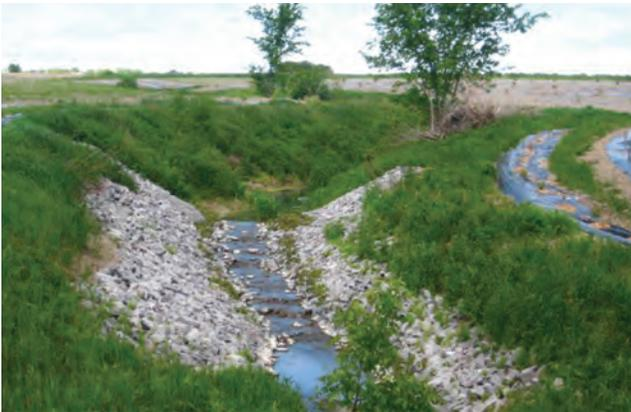
*Ci-dessus, aménagement de seuil dissipateur d'énergie pour stabiliser le fond du cours d'eau et limiter l'érosion et, à droite, travaux de reprofilage et de génie végétal (tressage) pour stabiliser les berges.*
