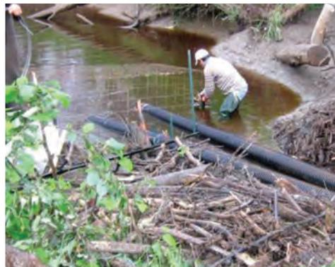
À droite, aménagement d'un cube Morency pour contrôler le niveau d'eau d'un réservoir établi derrière un barrière de castor tout en limitant les impacts sur l'agriculture. Ci-dessus, une jeune haie brise-vent.
