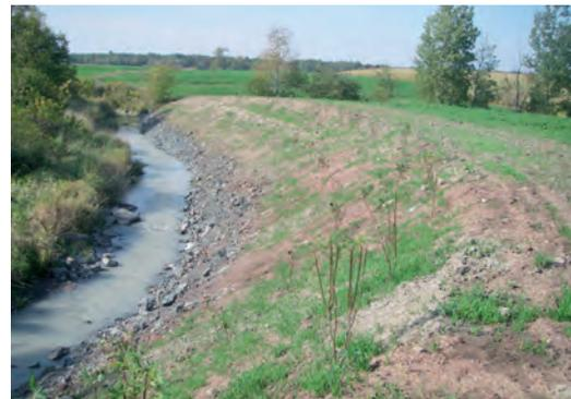
*Dans cet exemple de berges dégradées, les mesures de correction expérimentées ont été une combinaison de techniques : reprofilage de la pente pour l'adoucir, enrochement des berges pour les renforcer avec des matériaux solides et plantation de végétaux indigènes dans le haut du talus. S'ajoute l'adoption de pratiques de conservation des sols comme le travail réduit du sol et le semis direct.*
