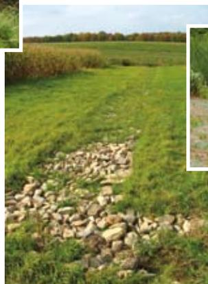
Des déversoirs en bordure du cours d'eau et des voies d'eau engazonnées, drainant les eaux de ruissellement, préviennent l'érosion et le ravinement des champs.
