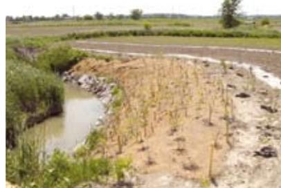
L'encochement, le nivellement et la plantation de végétaux stabilisent les berges sensibles à l'érosion.
