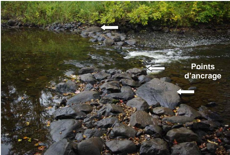
Photo 1. Seuil en roches où des points d'ancrage ont été utilisés pour stabiliser l'ouvrage.
