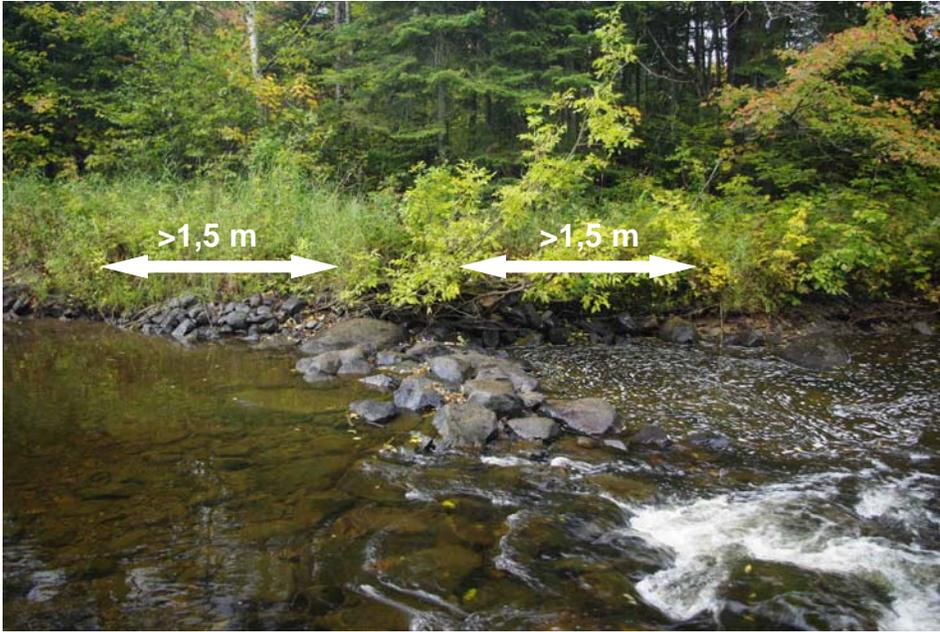
Photo 5. Enrochement de la rive en amont et en aval du seuil en roches.
