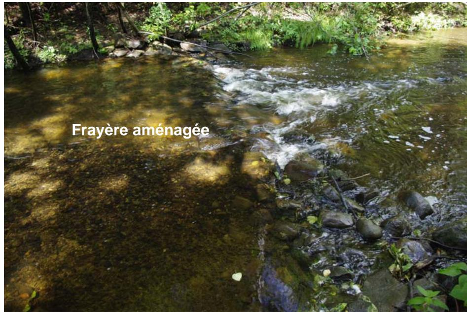
Photo 11. Frayère aménagée à l'amont de l'échancrure d'un seuil en roches.
