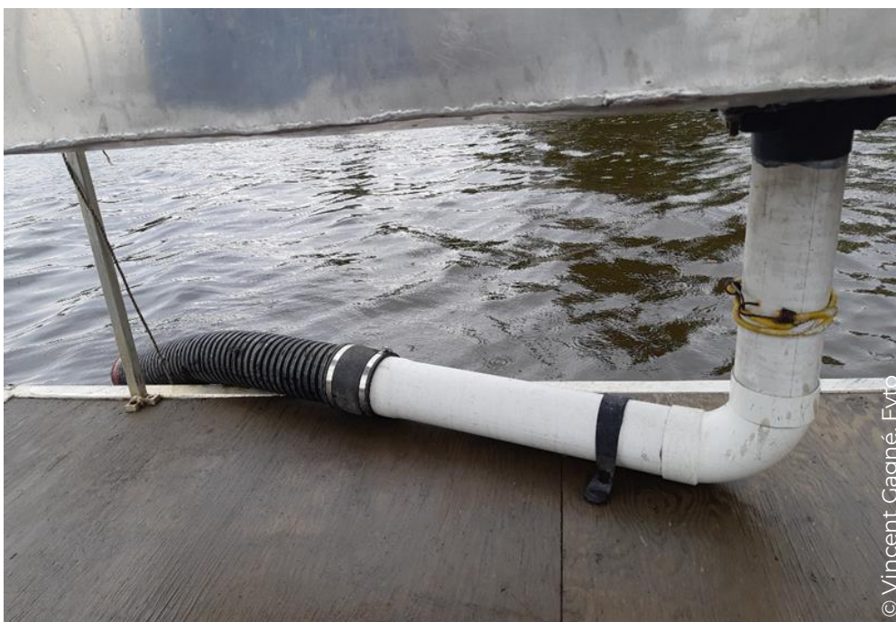
Figure 43. Rejet d'eau à l'arrière du ponton.
