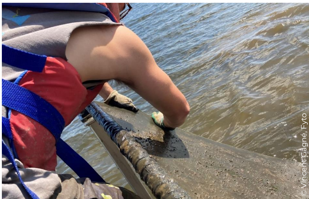
Figure 34. Application d'une tension en continue lors de l'enroulement de la toile.
