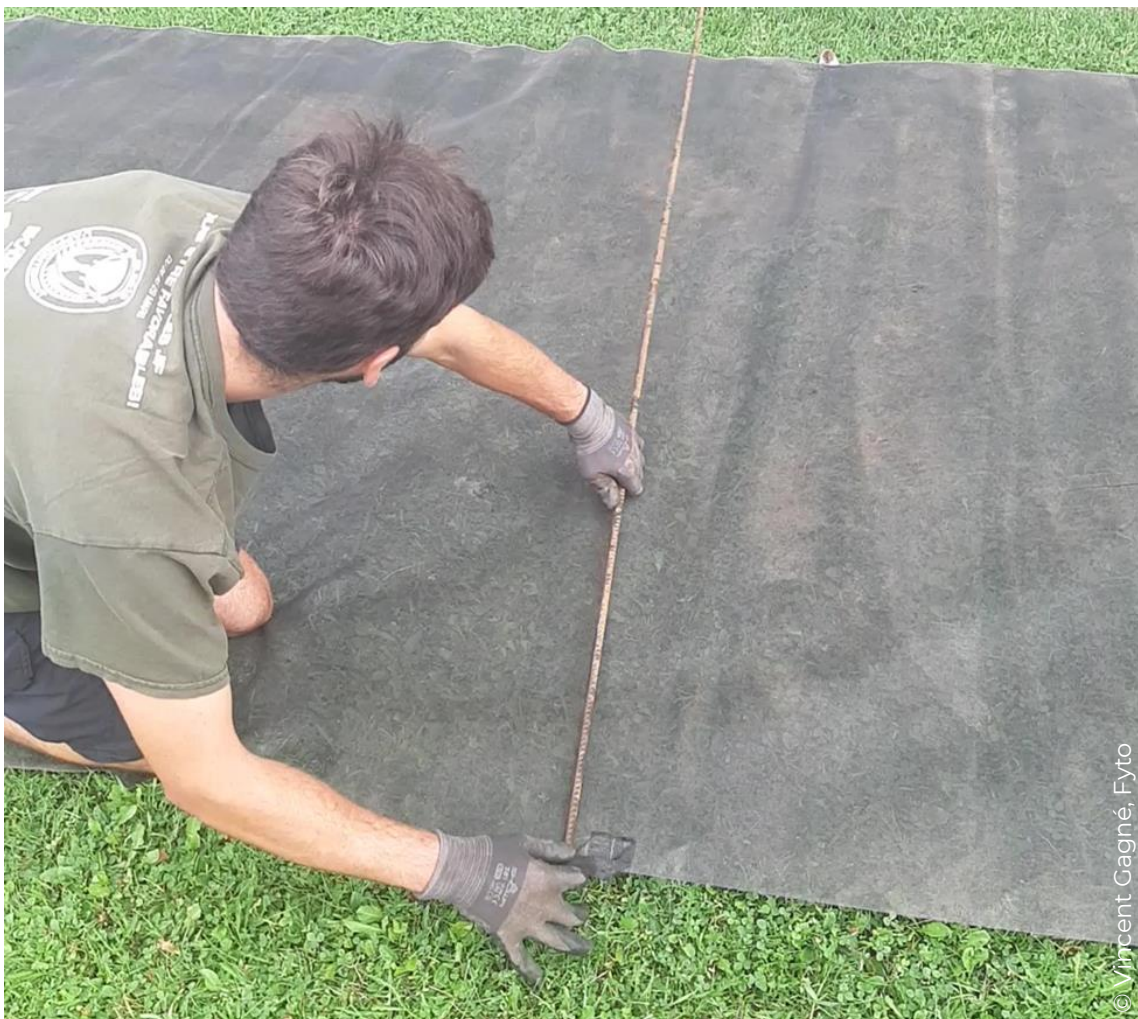
Figure 29. Formation d'installation des toiles, lestage.
