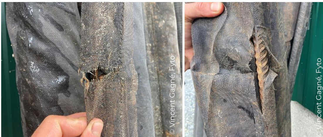
Figure 50. Exemple de bris sur les toiles.
