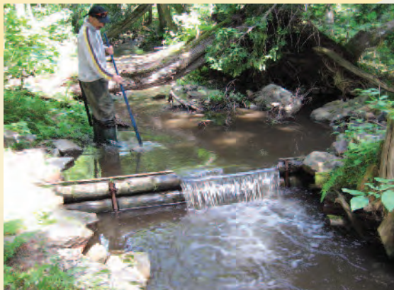
Réparation de seuils. Photo : Association des chasseurs et pêcheurs de la région de Matane
