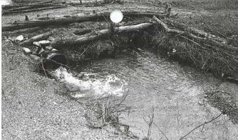
Photo 2 : Exemple de ponceau mal stabilisé apportant beaucoup de sédiments dans le cours d'eau
