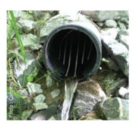
Figure 5. Sortie de drain avec grillage et enrochement empêchant l'accès des rats musqués au drain.
